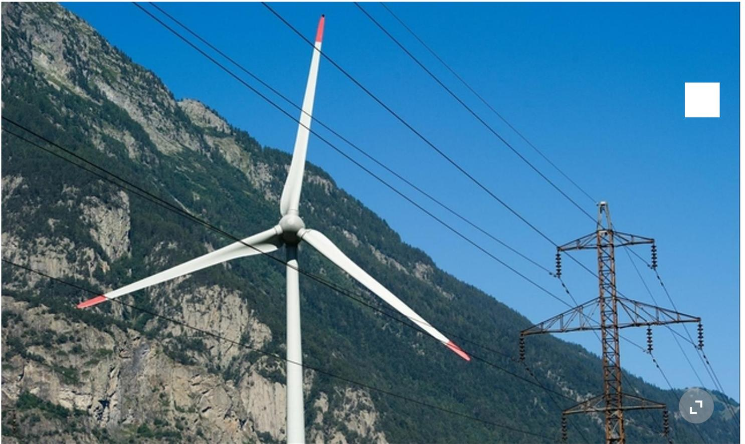
Windräder erbringen im Durchschnitt weniger als ein Fünftel der eigentlich möglichen Leistung: Windkraftanlage in Collonges bei Martigny im Wallis. (Foto: Keystone)
